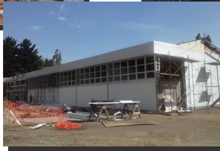
Avance de Obras, Dic. 2012
