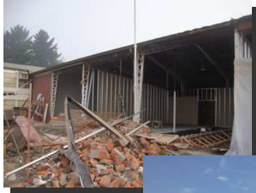
Inicio de Obras Oct. 2012
